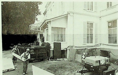
De renovatie van het Airborne Museum (onder leiding van Gerritsen Bouwgroep B.V. uit Renkuim) vordert gestang. (foto: B. de Reus)
