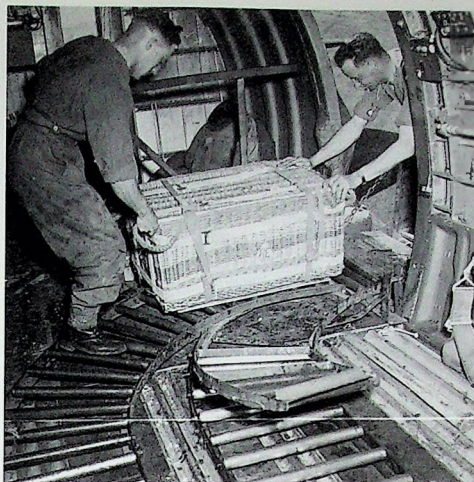
Militairen van het Royal Army Service Corps laden een mand met voorraden in een Dakota. Op de voorgrond zijn op de vloer de rollerbanen zichtbaar waarover de manden konden worden geschoven. Dit vergemakkelijkte en versnelde het laden en het uitwerpen door de Air Despatchers. De foto staat ook in Frank Steers boek 'Arnhem, The Fight To Sustain'.
