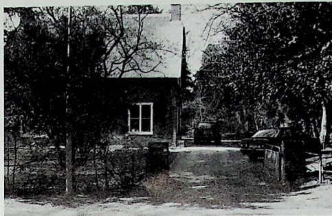
De huidige situatie. Nadat de villa was verwoest, werd in 1947/1948 een veel kleiner huis op die plaats gebouwd. Het hek dateert nog van voor de oorlog. Links achter de lantaarnpaal zit, nauwelijks zichtbaar, de krul in het hek. (Foto R. Voskuil, maart 1993)
